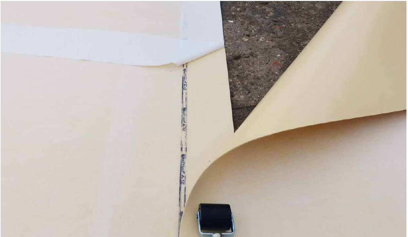
Membrane d'étanchéité de connexion sur le béton maigre
