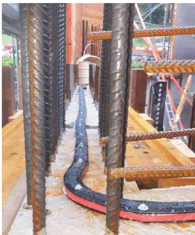
Réalisation dans les angles
