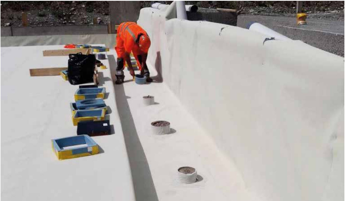
Membrane d'étanchéité sur radier et murs
