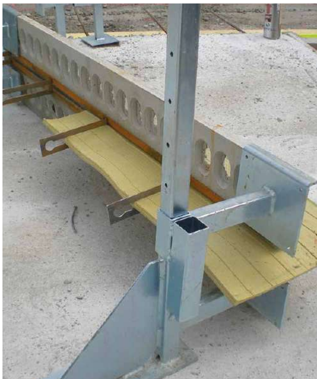
Joint fissuration p.e. avec ZEMBOARD
