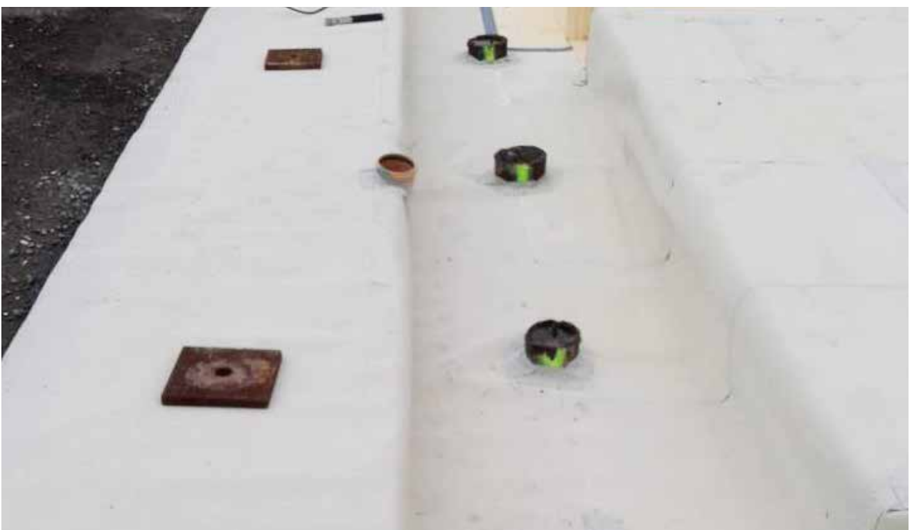
Membrane d'étanchéité pour béton frais avec réalisation de traversées
