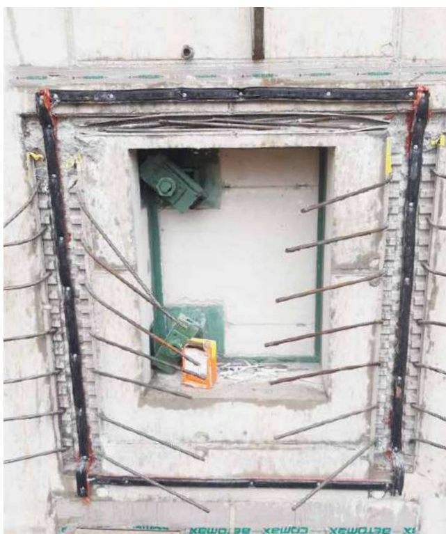
Réalisation pour raccordement
