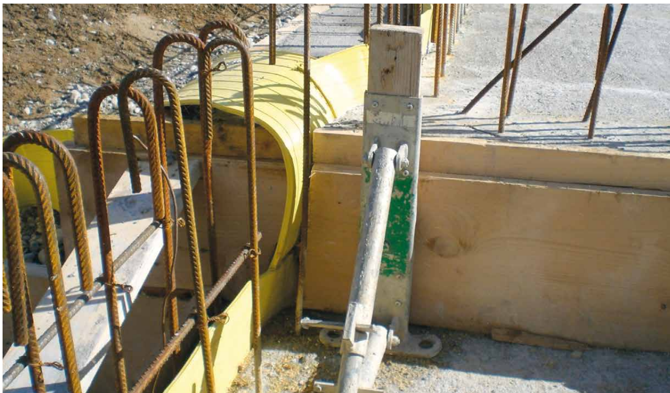
Bande de dénivèlement pour différentiel de hauteur de coffrage
