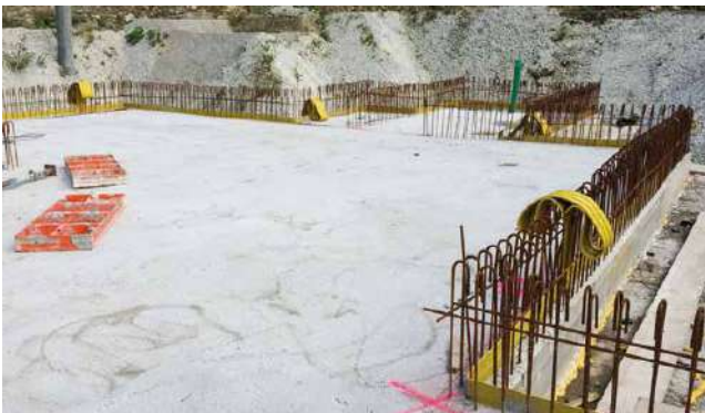
Joints R-M et M-M mis en place et soudés
