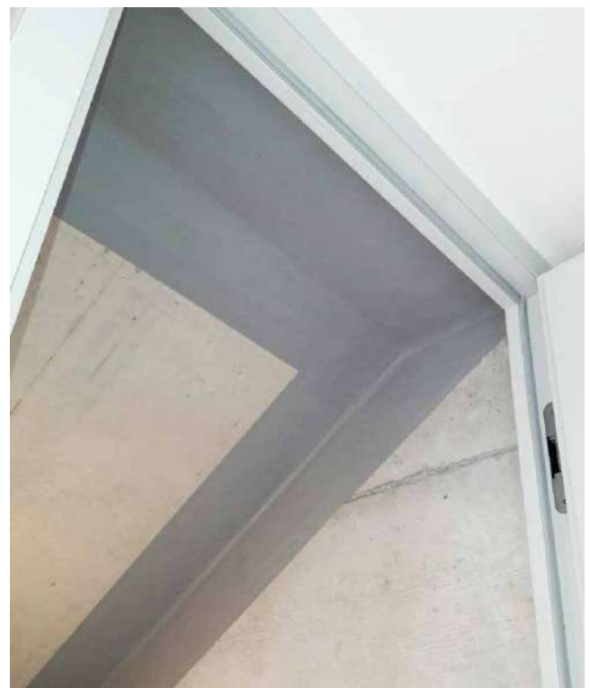
Réalisation rampe/escalier vue du dessous
