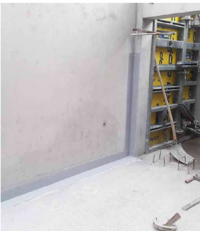
Réalisation de la reprise radier-mur intérieur en bande collée
