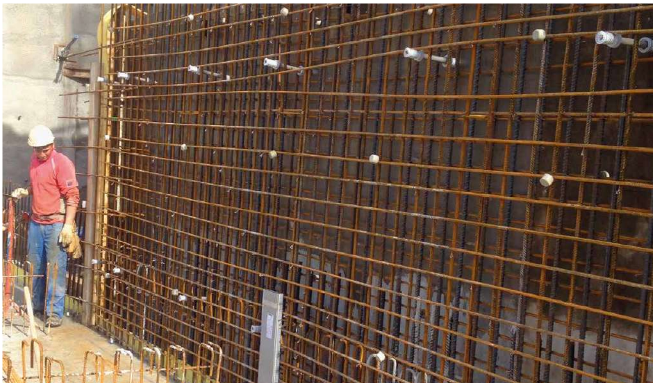
Ecarteurs de coffrage \varnothing 18mm
