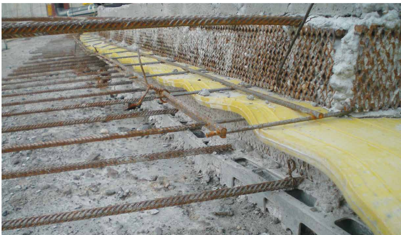
Element coffrage p.e. avec STREMAFORM
