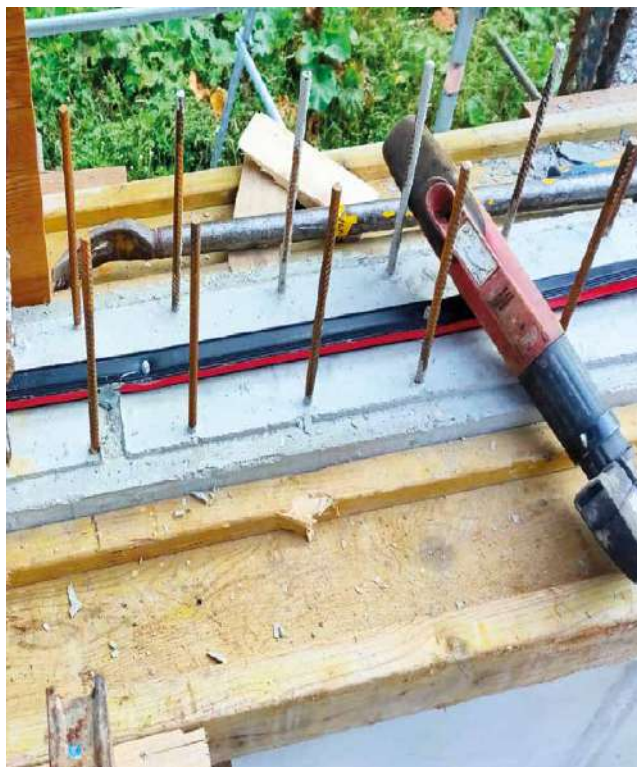
Le canal est ensuite fixé à l'aide de clous ou vis
