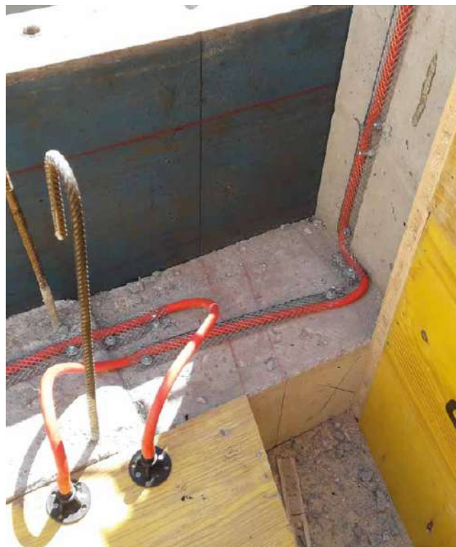
Tuyau injectable avec réalisation d'angle
