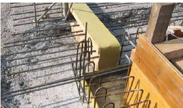
Joints R-R préparés sur coffrage et soudés
