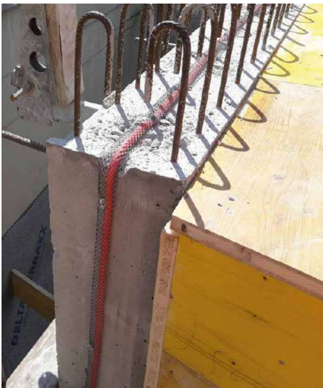
Tuyau avec grill de protection, reprise mur-mur
