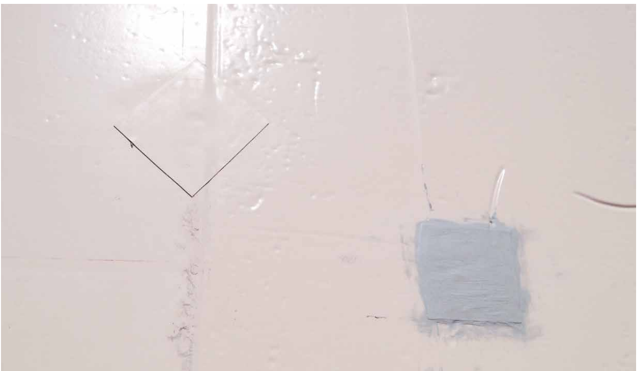
Fermeture des trous d'écarteurs dans la membrane avec patches ou colle epoxy
